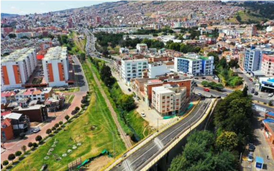
Foto: vista aérea del puente de Las Quintas
